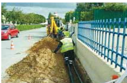
Substituição de um troço de conduta em fibrocimento DN 100mm, a passar no interior de quintais, por novo troço DN 90 em PVC na Urb. da Bemposta
