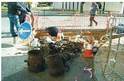
Substituição de válvulas na Rua Infante D. Henrique
