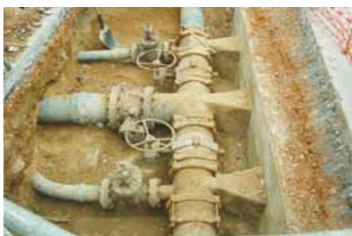
Substituição de um troço de conduta em fibrocimento DN 100mm, a passar no interior de quintais, por novo troço DN 90 em PVC na Urb. da Bemposta
