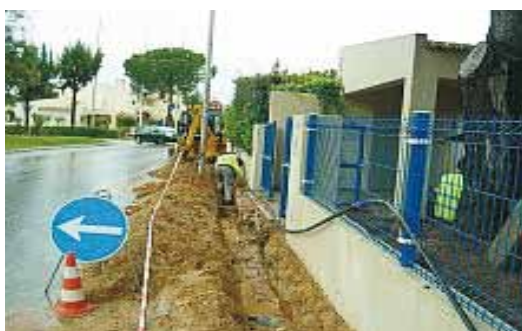
Substituição de um troço de conduta em fibrocimento DN 100mm, a passar no interior de quintais, por novo troço DN 90 em PVC na Urb. da Bemposta
