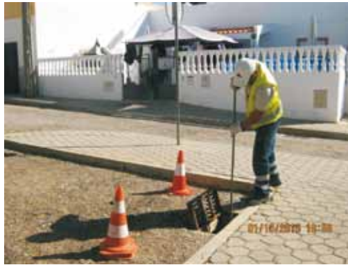
Limpeza de sarjetas
