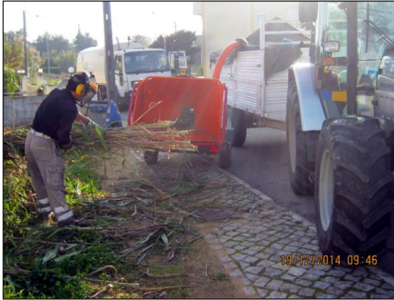
Limpeza e desobstrução de linhas de água
