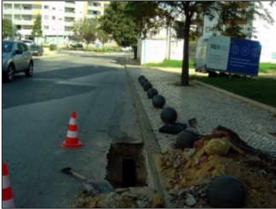
Duplicação e rebaixamento dos sumidouros existentes na Av. Miguel Bombarda e ruas transversais
