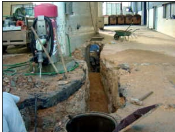
Execução de novo ramal de esgoto doméstico nas fossas de lavagem dos RSU
