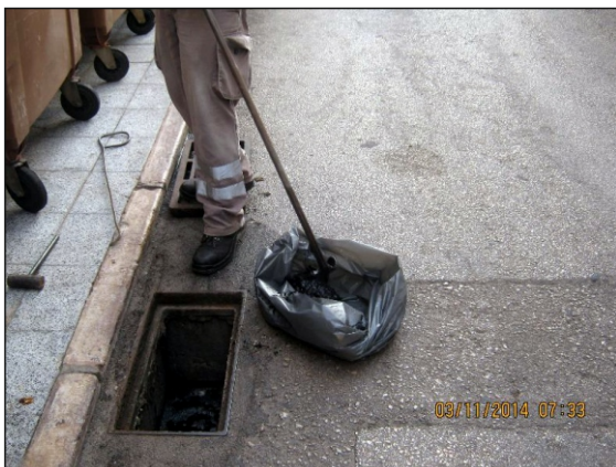
Limpeza de sarjetas
