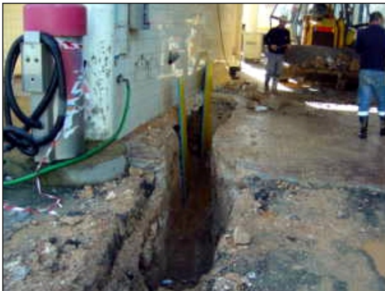
Execução de novo ramal de esgoto doméstico nas fossas de lavagem dos RSU
