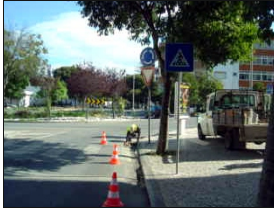
Duplicação e rebaixamento dos sumidouros existentes na Av. Miguel Bombarda e ruas transversais
