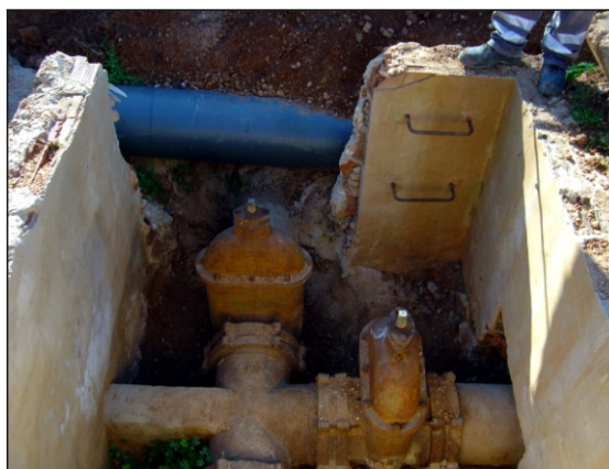
Substituição de válvulas DN 350 mm junto ao Reservatório da Boavista
